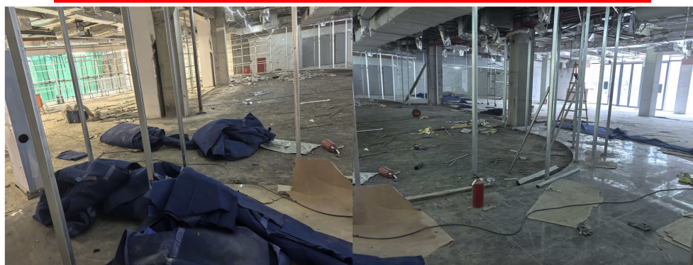
图3-17 2026 年 1 月 20 日上午 10 点拍摄，南楼 1 楼大堂情况
