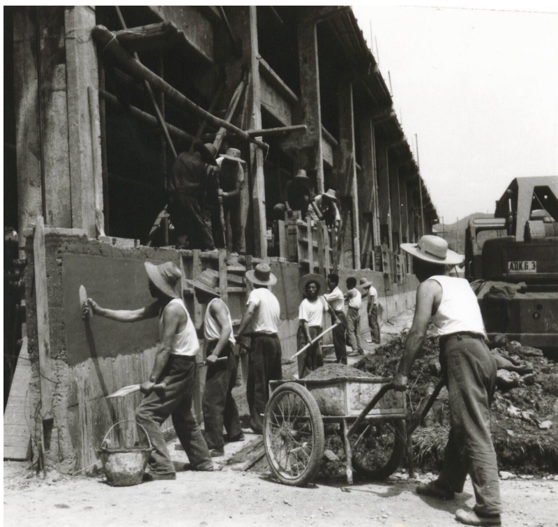
图3 二汽工地上热火朝天的建设场景（图源：东风公司资料室）
